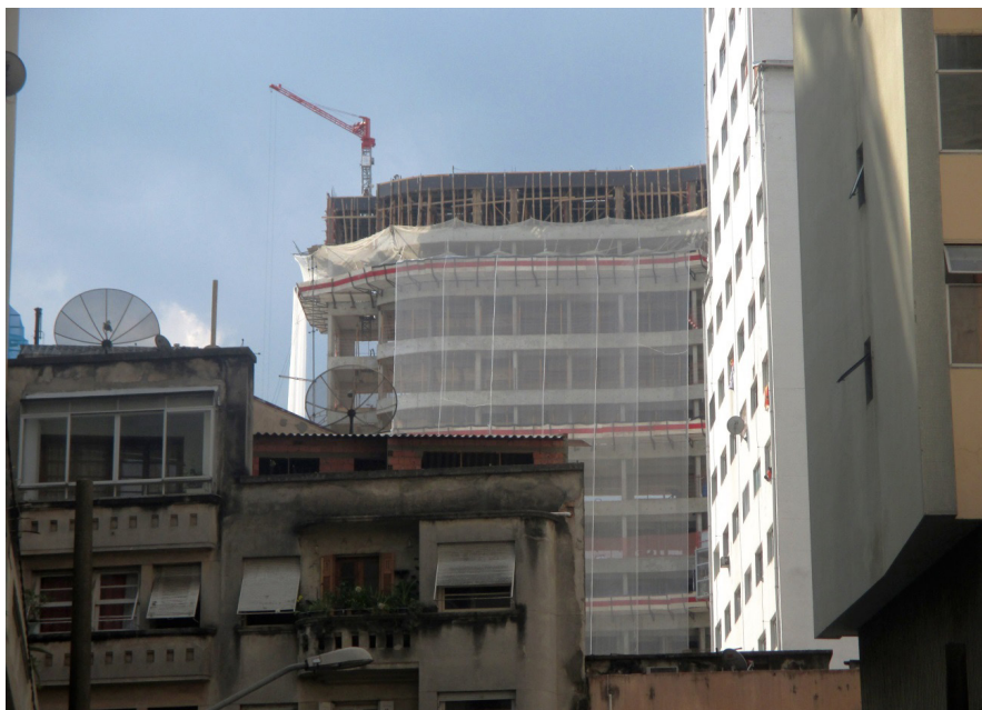
Figura 10 - Novos empreendimentos surgem em meio ao cenário de edifícios antigos e deteriorados
