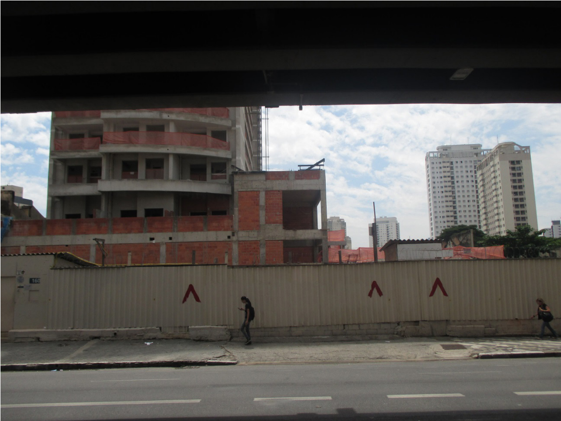
Figura 15 - Novo condomínio erguido à beira do Elevado João Goulart, popularmente conhecido como Minhocão, obra viária responsável por depreciar o preço dos imóveis em seu entorno
