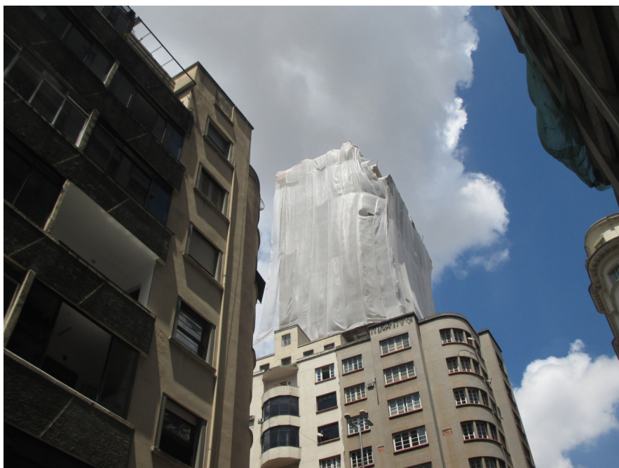
Figura 9 - Edifícios construídos em meados da década de 1940 junto com prédio novo na República
