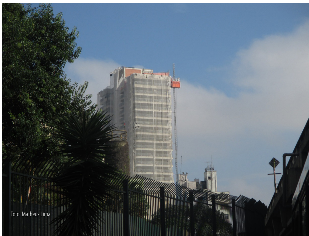
Figura 14 - Novo condomínio erguido próximo ao Elevado João Goulart, popularmente conhecido como Minhocão
