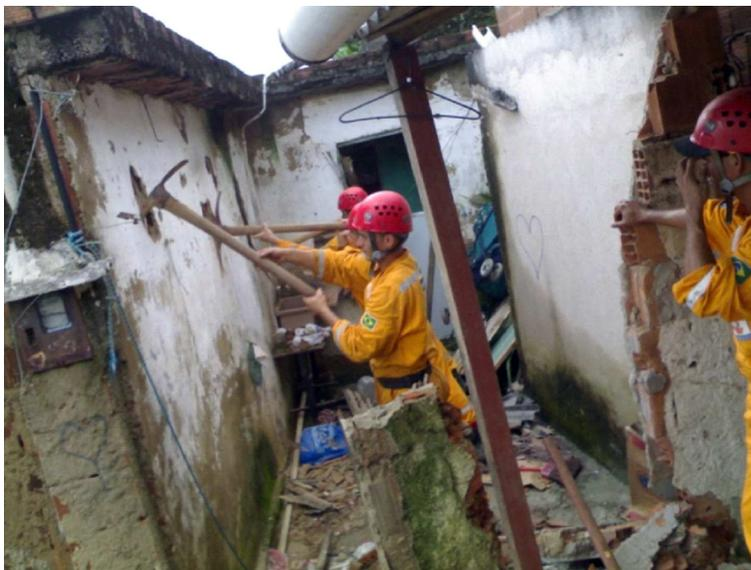
**Figura 1** Equipe de agentes de defesa civil de Angra dos Reis responsável pela demolição de moradias condenadas pela engenharia. (Foto do acervo da defesa civil de Angra dos Reis.)
