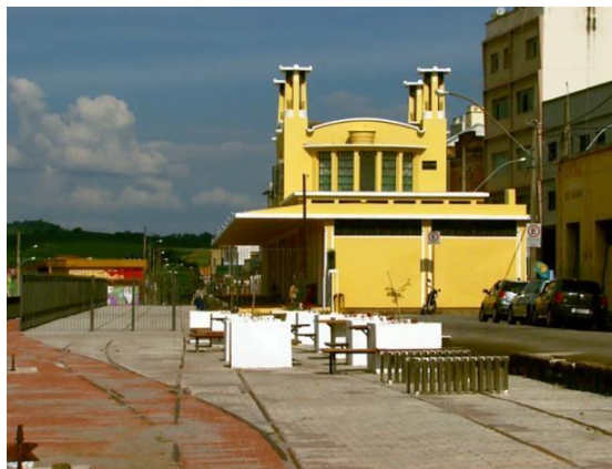
FIGURA 3 – Depois da requalificação
