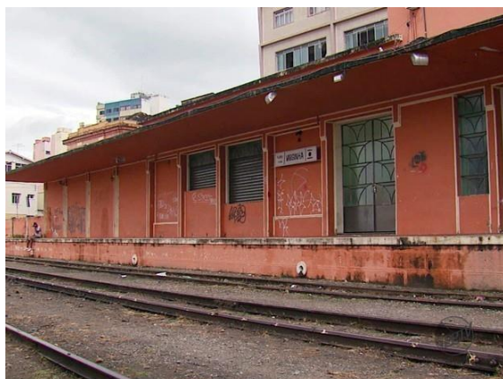
FIGURA 2 – Antes da requalificação
