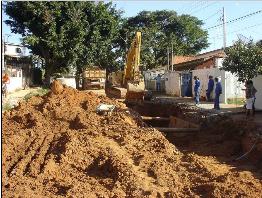
Implantação da rede de esgoto no Jardim Amanda II. Foto: Luiz Tiago de Paula (maio, 2008).
